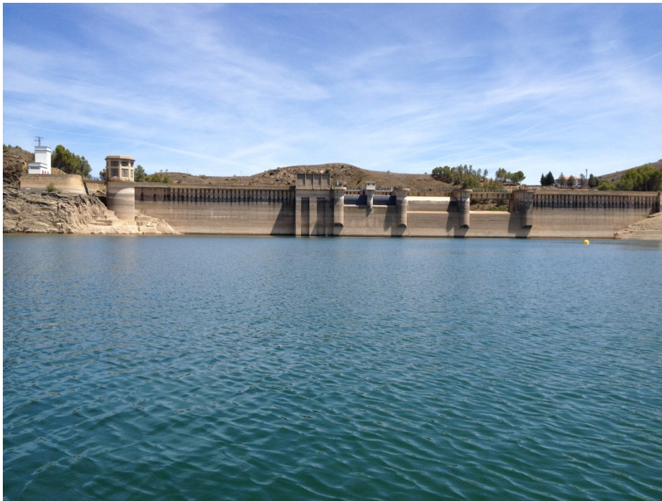
Figura 7. Vista de la presa del embalse
