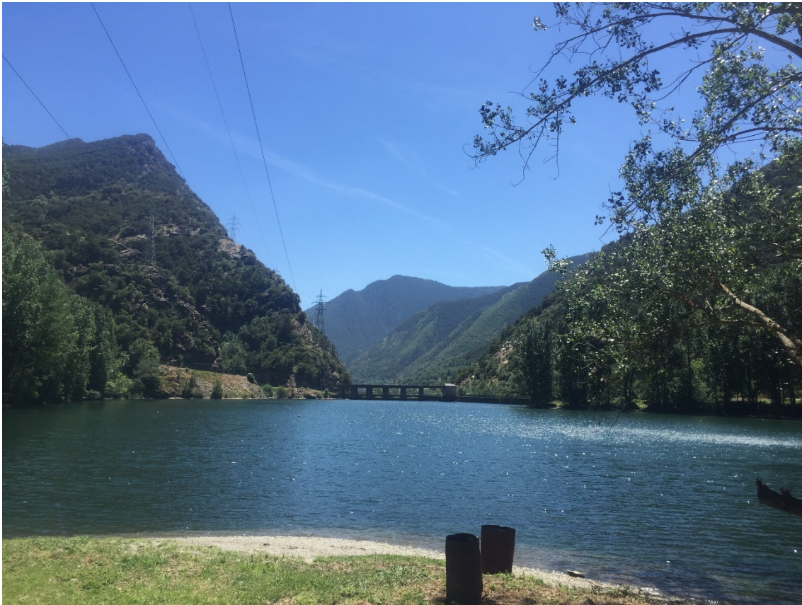
Vista general del Embalse de la Torrasa
