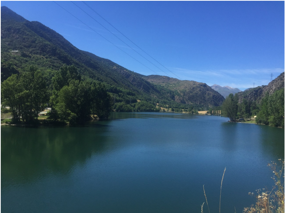
Vista general del Embalse de la Torrasa
