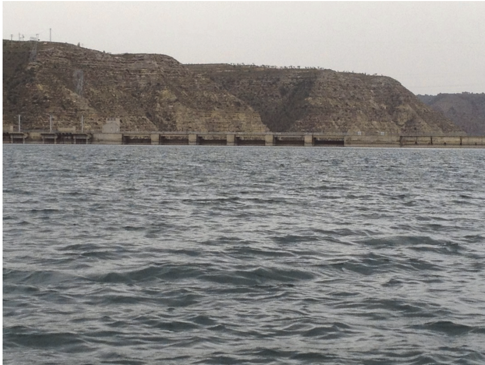
Figura 7. Vista de la presa del embalse
