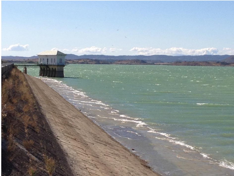
Figura 7. Vista de la presa del embalse
