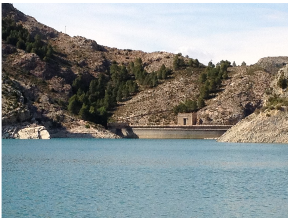
Figura 7. Vista de la presa del embalse
