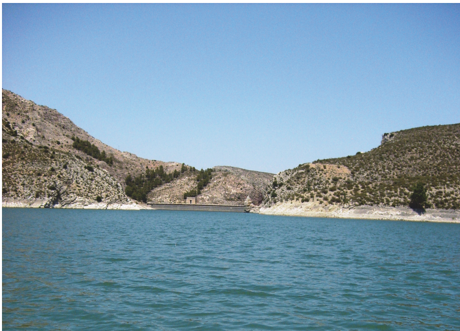
Foto 1: Vista de la presa del embalse
