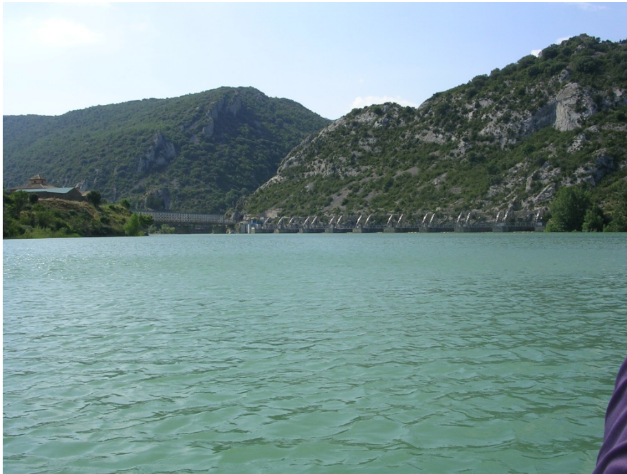
Figura 9. Vista de los aliviaderos del embalse
