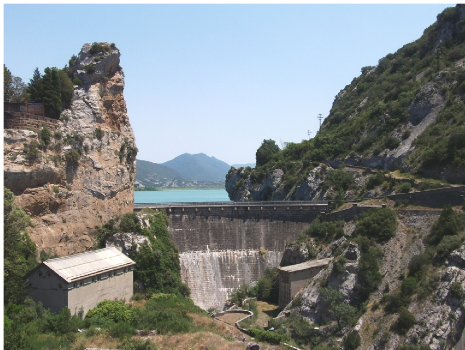
Figura 7. Vista de la presa del embalse
