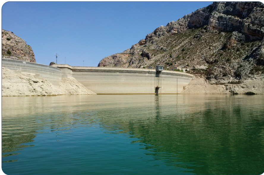
Figura 2. Vista de la presa del embalse de Cueva Foradada
