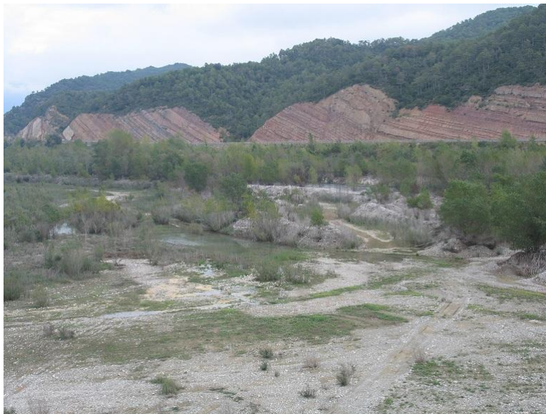
Figura 49-17. Alteraciones en la ribera del Segre en las inmediaciones de la localidad de Aguilar
