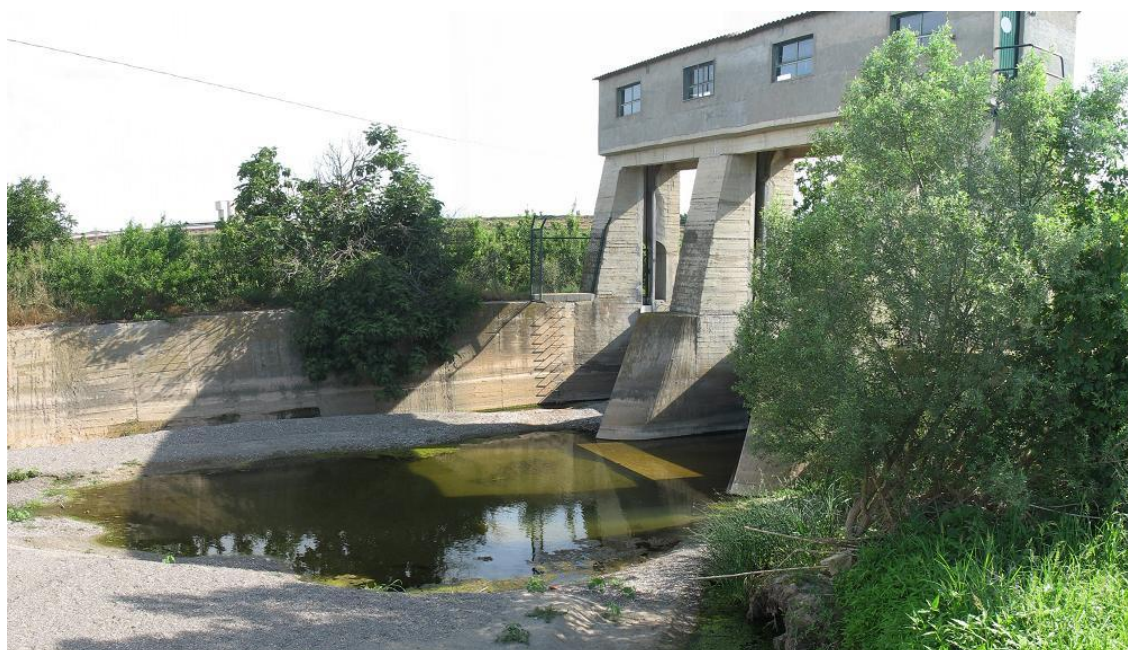
Figura 49-86. Azud en el cauce bajo del río Corp.
