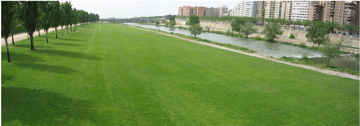
Figura 49-40. Canalización con alteración de márgenes y lecho del río Segre en la ciudad de Lleida.
