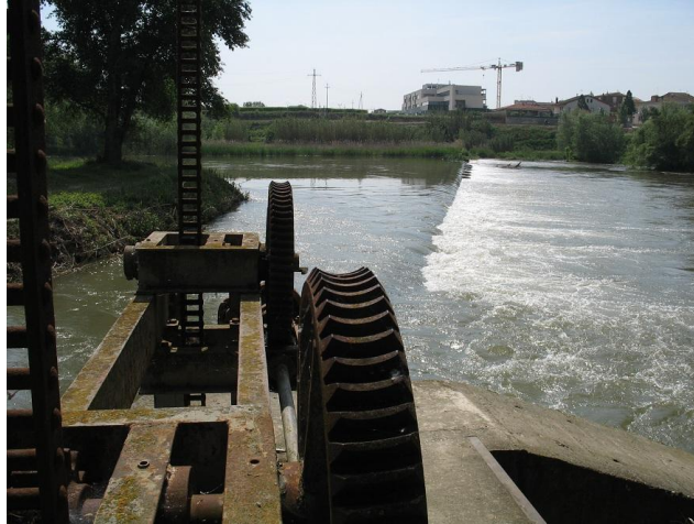
Figura 49-43. Azud de derivación en Torres de Segre.
