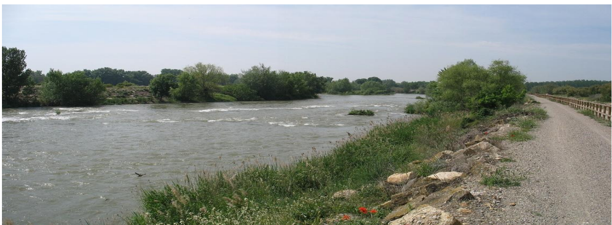
Figura 49-41. Defensa de margen y eliminación del corredor ribereño en el río Segre entre las localidades de Butsenit y Lleida.
