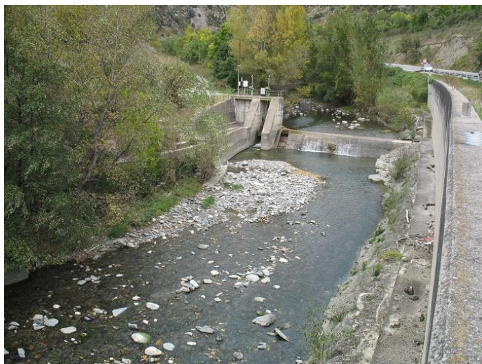
Figura 49-52. Derivación de caudales en el río Valira.
