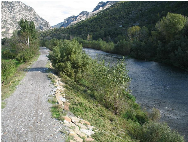
Figura 49-13. Ejemplo de defensa lateral y reducción de la ribera en el río Segre cerca de la localidad de Organya.
