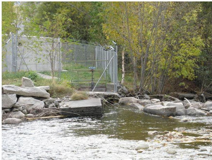
Figura 49-48. Pequeña derivación de caudales en el río Arabo.
