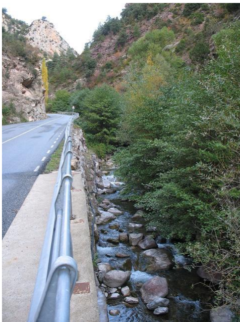
Figura 49-57. Defensa de margen en un afluente del río Pallerols.
