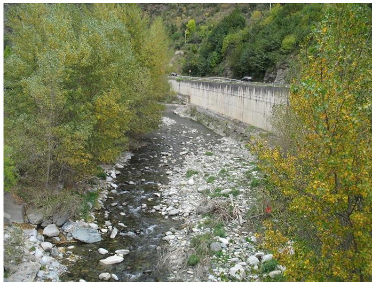
Figura 49-53. Defensa de margen para el paso de la N-145 en el acceso al principado de Andorra.
