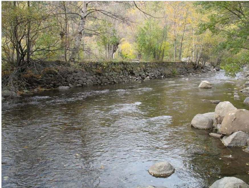
Figura 49-49. Defensa de margen en el río Arabo.
