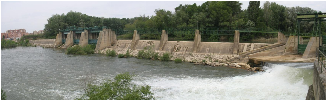
Figura 49-39. Azud de derivación en el río Segre en las proximidades de la localidad de Lleida.
