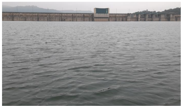
Presa embalse de Rialb (noviembre 2024).
