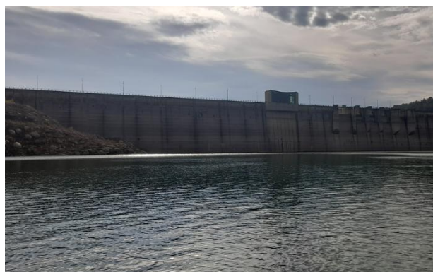
Presa embalse de Rialb (noviembre 2023).
