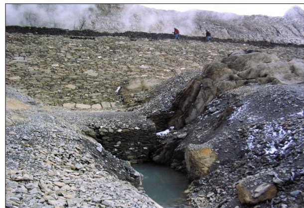
Imagen de la represa, rota en la base de modo que no modifica la hidrodinámica del ibón
