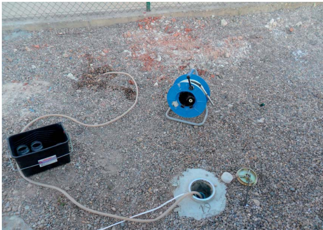
■ FIGURA 5.3.38 PURGADO DE UNO DE LOS NUEVOS PIEZÓMETROS DE CONTROL. (07/03/2012). ZONA 079-01
