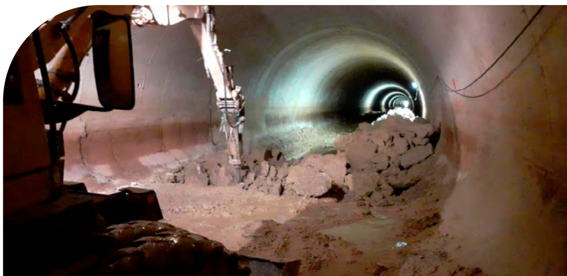
Mantenimiento del túnel de Farasdués
