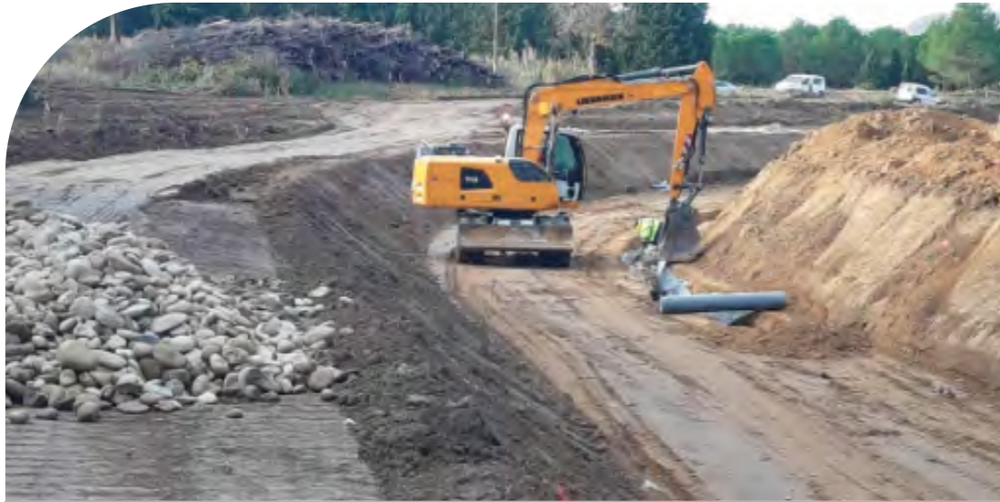
Excavaciones en emosario La Sotonera
