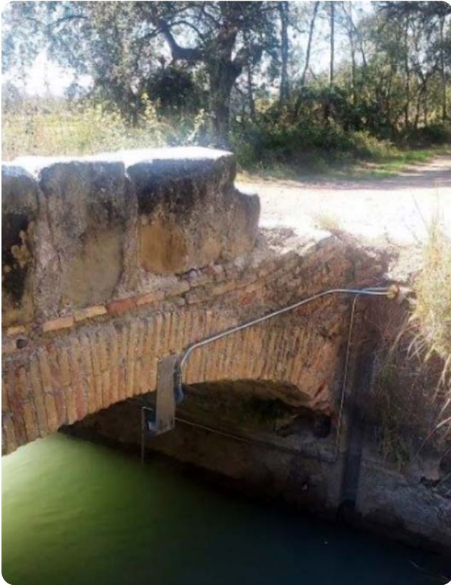
Nueva instalación en la acequia de Camarera, Bajo Gállego.
