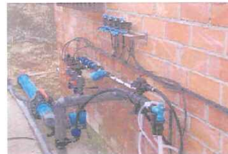
Figura 2.25. Sistema de fertirrigació
