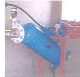
Figura 2.21. Filtre de malles
