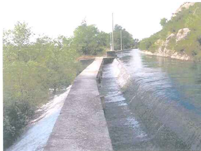
Figura 1.8.4. – Imatge aigües avall de l'obra de captació. Retorn al riu en sortir de la mina.
