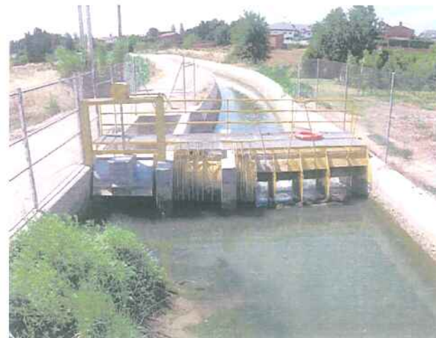
Figura 1.8.27. – Comporta modulable o màscara
