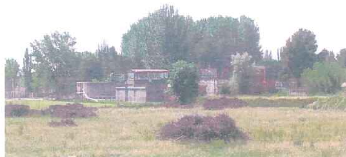
Figura 1.8.63. –Punt de captació 2 d'Aigües Lleida a la Sèquia del Cap
