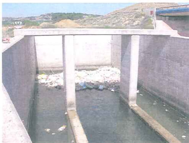
Figura 1.8.21. – Sífó del Séquia del Cap de creuament de l'autovia N-II
