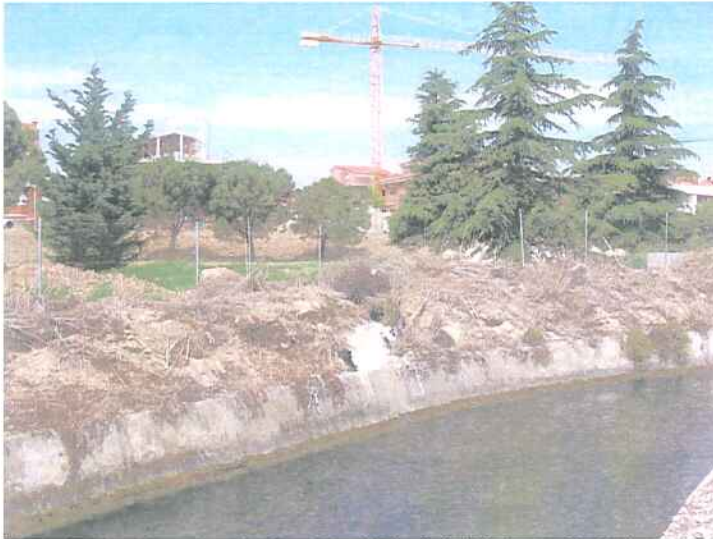
Figura 1.8.38. – Punt de caiguda al Canal Principal d'aigües residuals i/o pluvials d'una urbanització de Torrefarrera.
