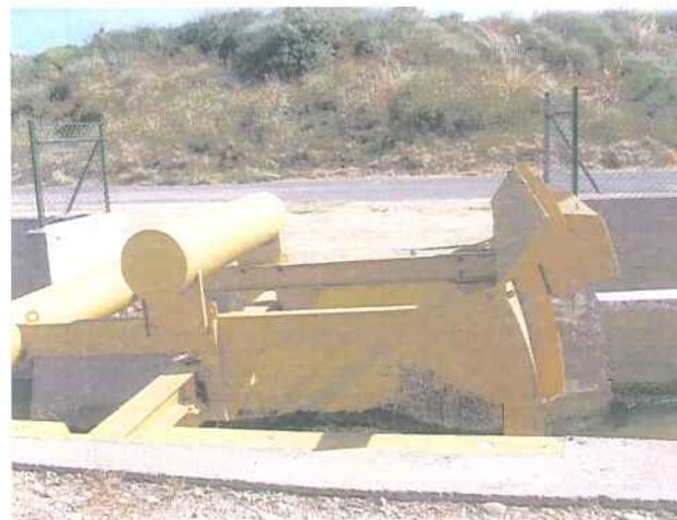
Figura 1.8.19. – Comporta automàtica nivell constant
