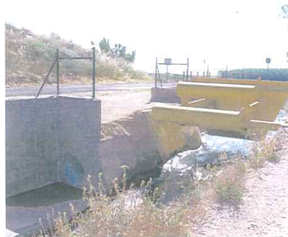
Figura 1.8.20. – Comporta automàtica nivell constant
