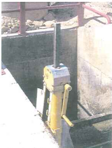
Figura 1.8.26. – Comporta amb actuador de cremallera
