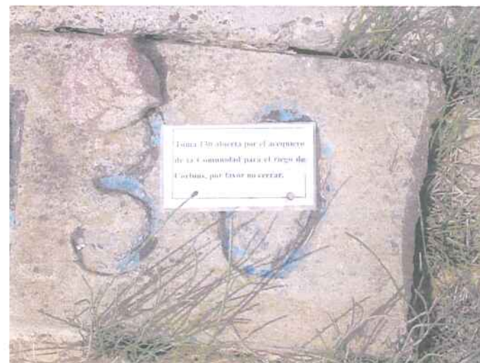
Figura 1.8.30. – Avis d'obertura del punt de presa 130 sobre el Canal Principal
