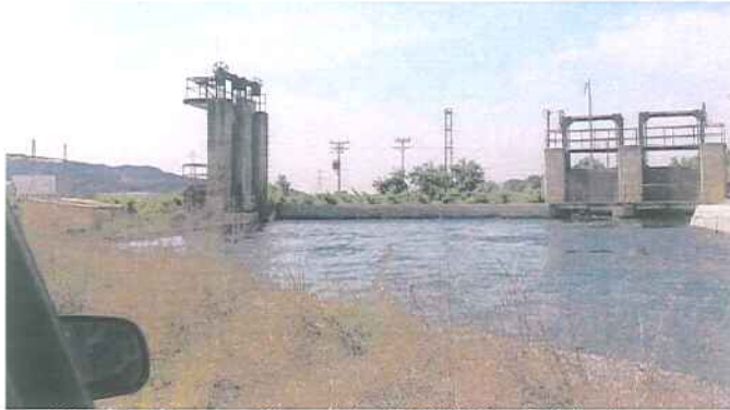
Figura 1.8.8. – Punt de retorn d'aigua al riu a l'inici del Canal Principal
