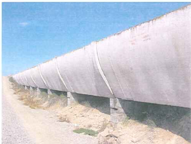
Figura 1.8.25. – Tram en aqüeducte
