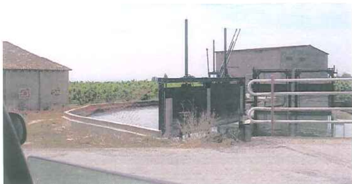
Figura 1.8.52. – Salt del Molinot (Canal Principal)
