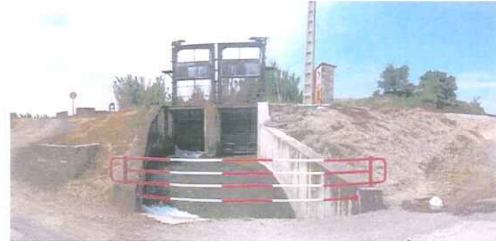
Figura 1.8.10. – Punt de desguàs de l'Ull Roig
