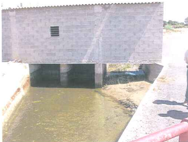
Figura 1.8.23. – Angles de Torrefarrera
