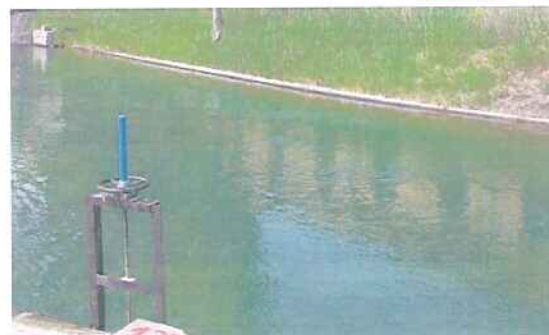
Figura 1.8.11. – Comporta punt de presa del Canal Principal
