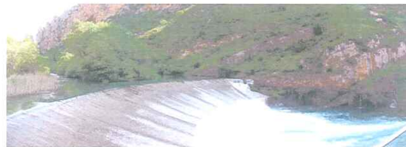
Figura 1.8.1. – Assut de captació del canal de Pinyana
