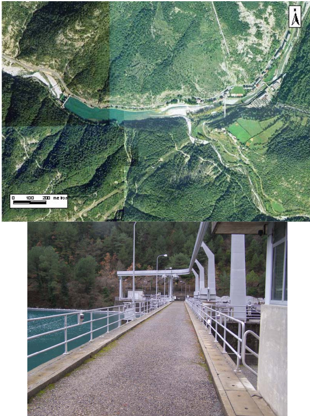
Figura 2.60: Vista general del Embalse de Laspuña.
