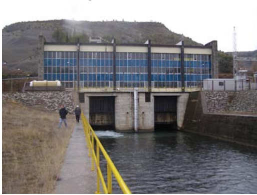
Central Hidroeléctrica de Laspuña. Río Cinca. Compuertas de Desagüe.
