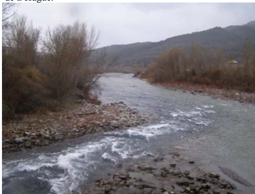
Central Hidroeléctrica de Laspuña. Canal de Desagüe en el río Cinca
