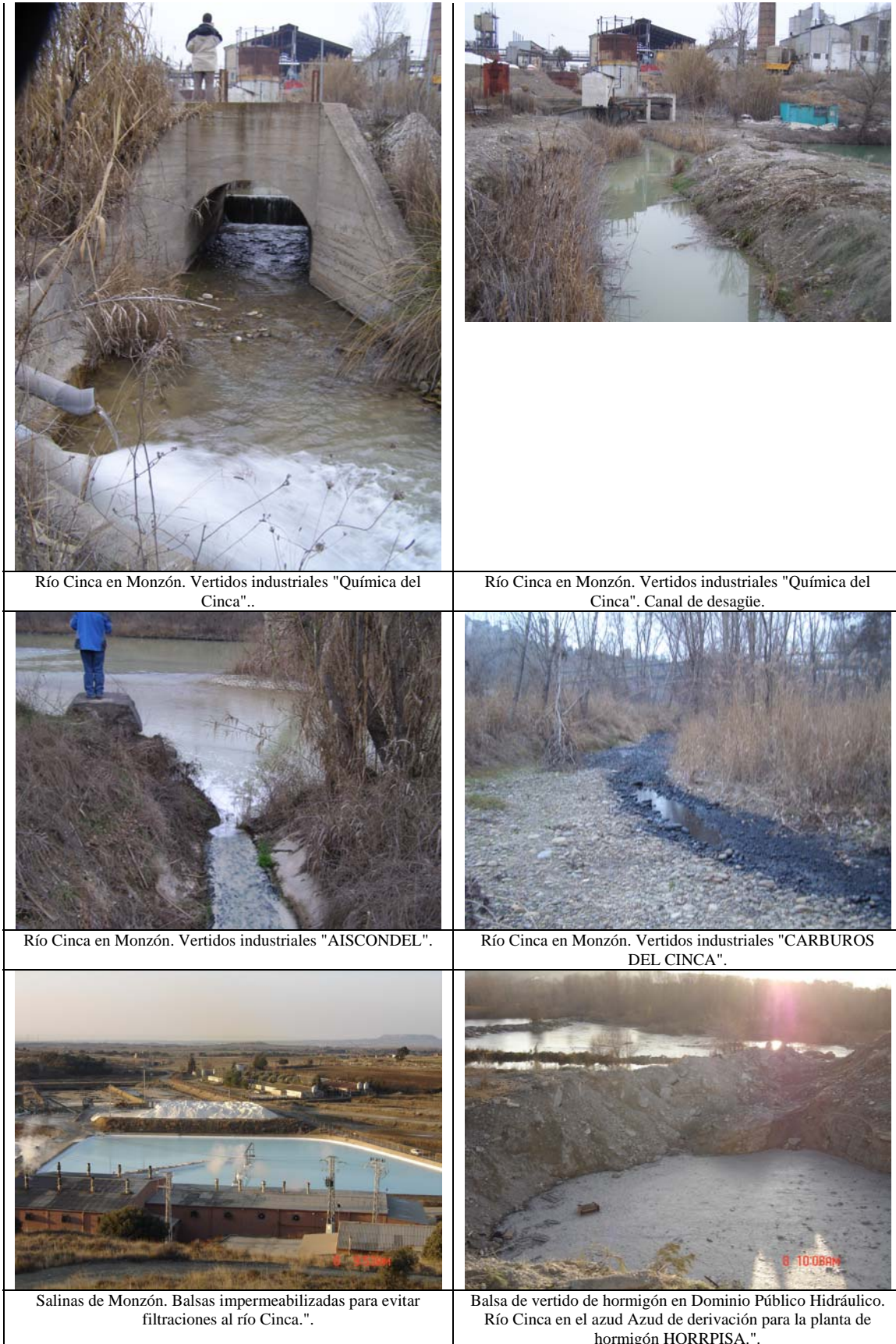
Figura 3.66: Fotos representativas de las características y problemas del Río Cinca desde el río Vero hasta el río Sosa. (436).
