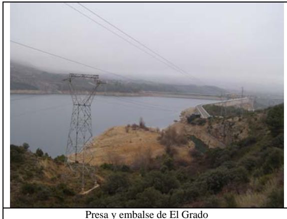
Presa y embalse de El Grado
