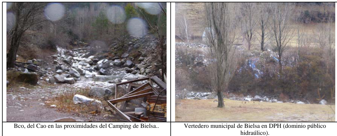
Figura 3.6: Fotos representativas de las características y problemas del Río Cinca desde el río Barrosa (inicio de la canalización del Cinca ) hasta el río Cinqueta. (746).
