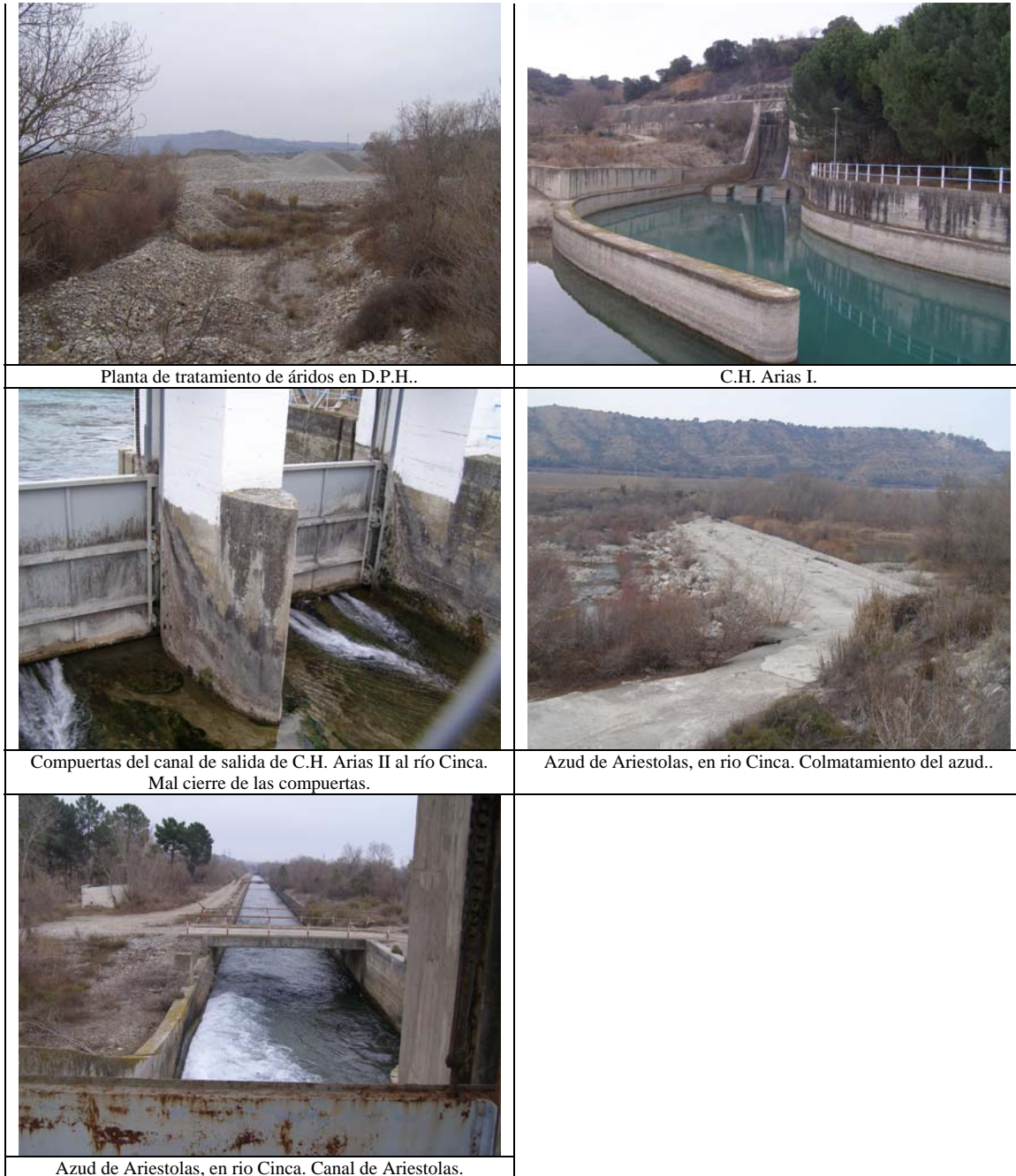
Figura 3.60: Fotos representativas de las características y problemas del Río Cinca desde el río Ésera hasta el río Vero. (435).
