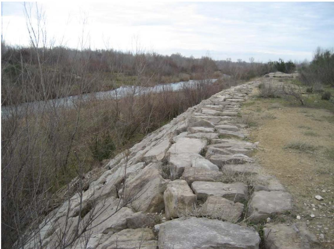
Ref. 36.- Detalle de la escollera de protección realizada en la margen izquierda del río Alcanadre aguas arriba del puente de Castejón.
