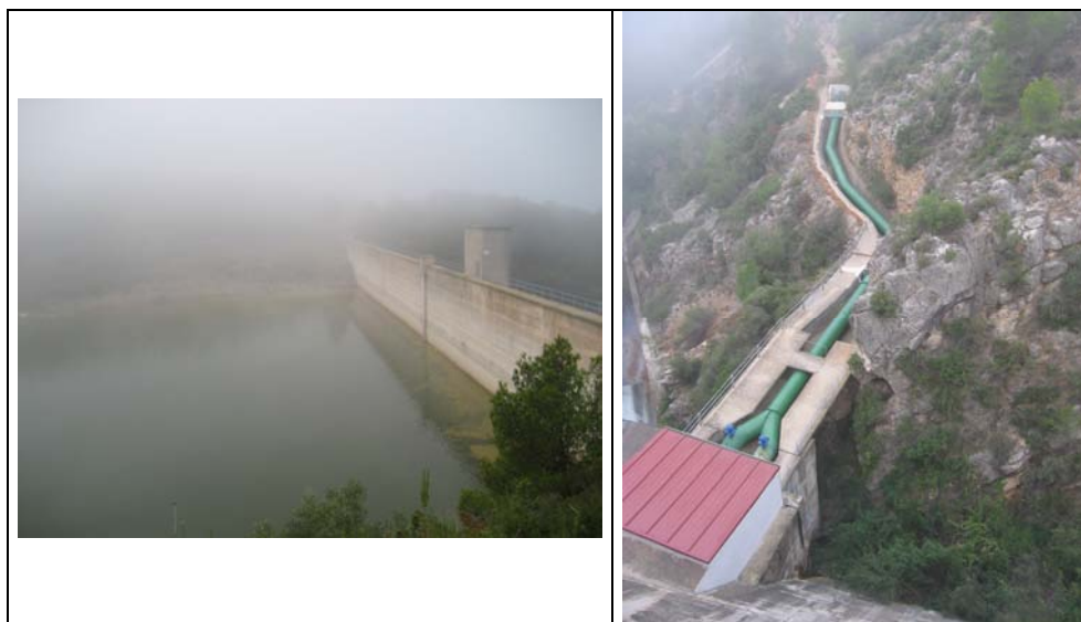
Figura 2.51 (continuación): Embalse de Guiamets. Foto general de la presa del embalse y de la toma de la Comunidad de Regantes de Guiamets situada en la misma (octubre 2008).
