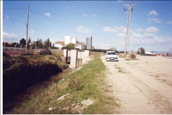
Sección de aforo en el canal l'Escortxador. Recoge las descargas regionales hacia el delta del Ebro.
