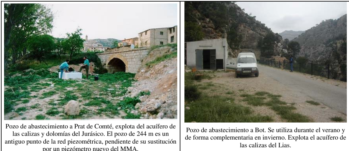
Figura 3.59: Fotos representativas de las características y problemas de la masa subterránea de los Puertos de Beceite
