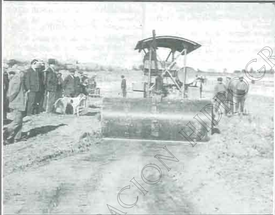
1.— Tractor oruga "Cletrac", cuya rapidez y facilidad de giro, le hace ser muy adecuado para trabajos de nivelación.
