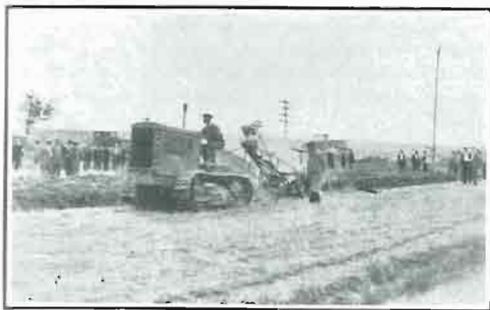
Otro momento de las pruebas de labrar con el arado báscula
