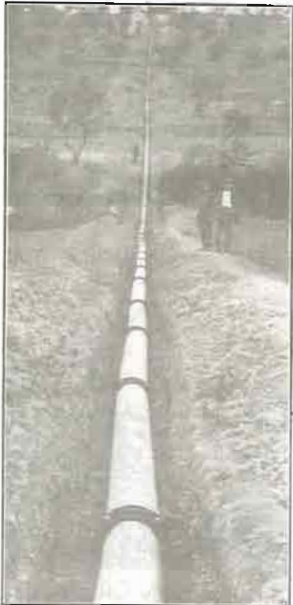
CONDUCCIÓN DE AGUAS EN CERVERA (Lérida) 1085 metros longitud. - 250 m/m diámetro. - 10 atmósferas
