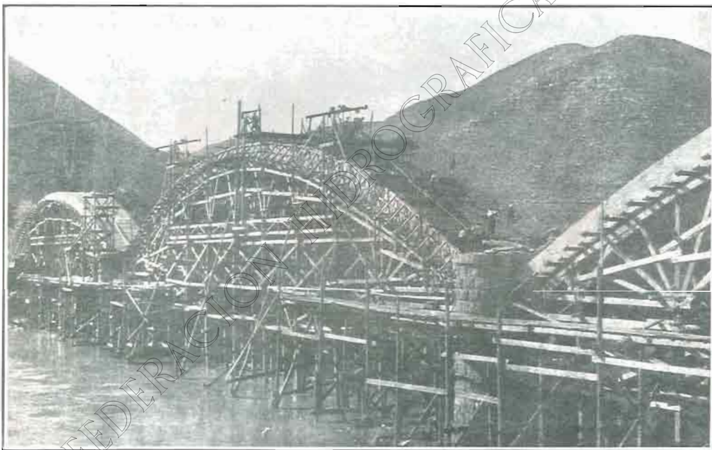
Puente en construcción sobre el río Ebro, en Mequinenza, con Cemento SANSÓN
