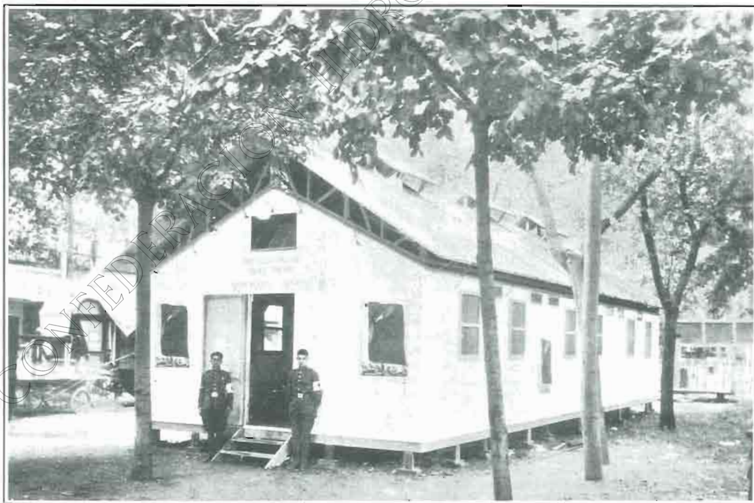
El pabellón sanitario
