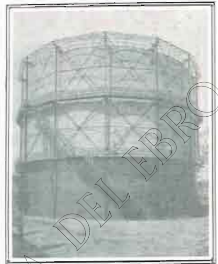
Gasómetro de Hierro Puro ARMCO construido por la Compañía municipal de Gas en Tilburg (Holanda).
