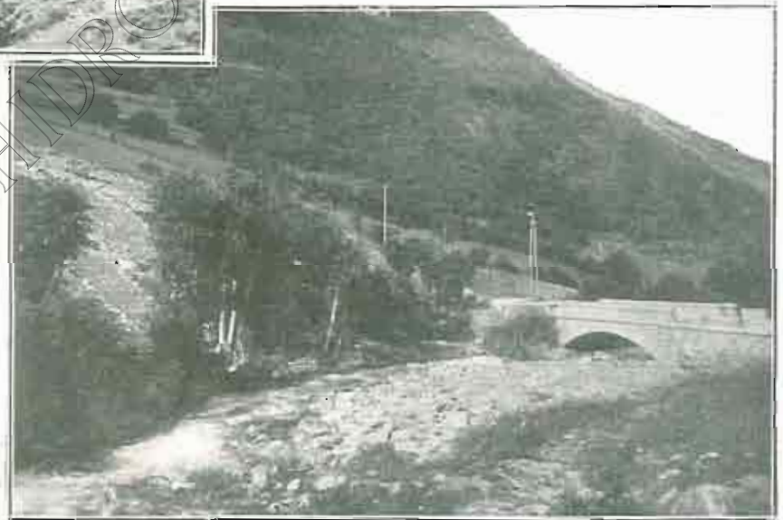
RÍO BONAIGUA. — "Puente de la cadena", cuya luz ha sido obstruida por los materiales arrastrados por la corriente.
