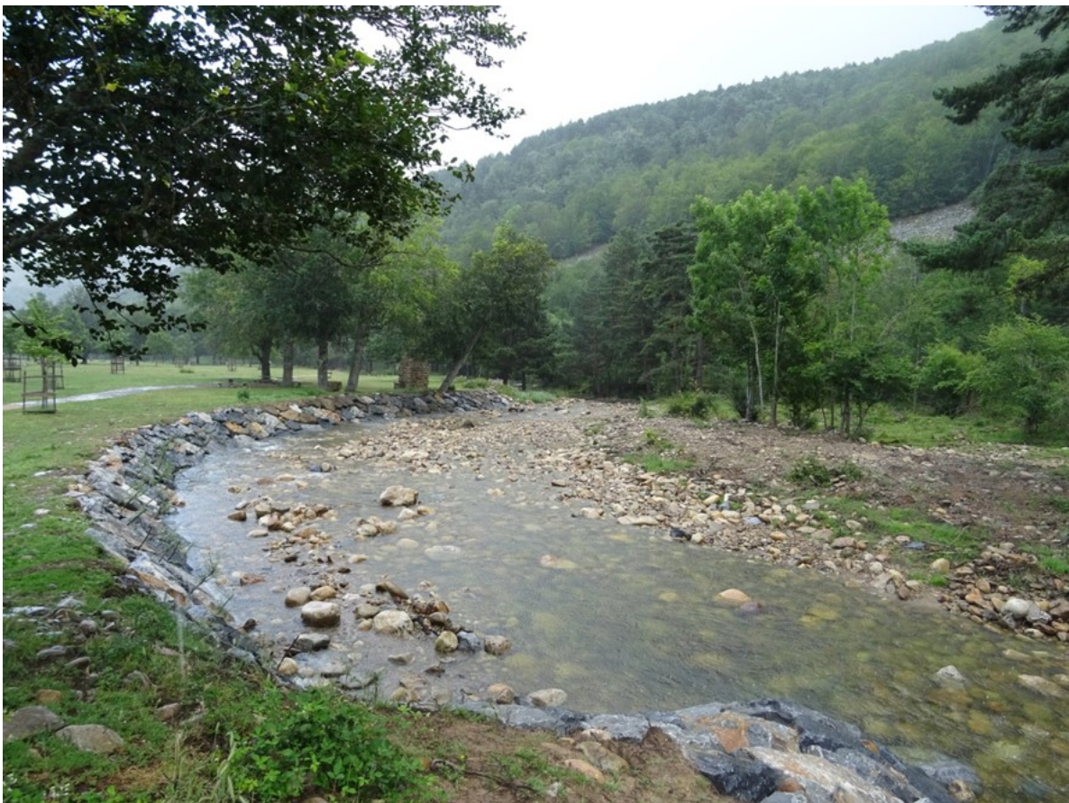
Escollera con técnicas de bioingeniería protegiendo el área recreativa "El Achichuelo"
