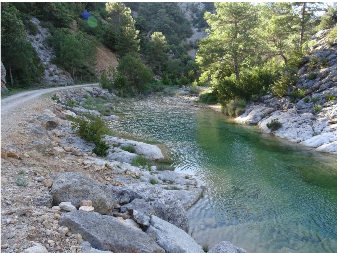
Pista y escollera de protección cerca de la ribera
