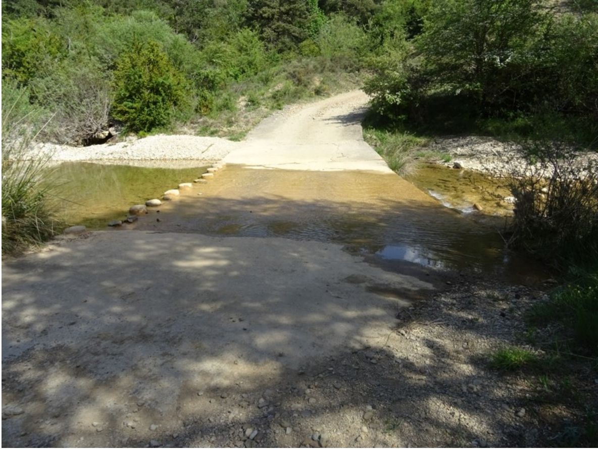
Paso sobre paramento con pequeño salto vertical al final del tramo 1
