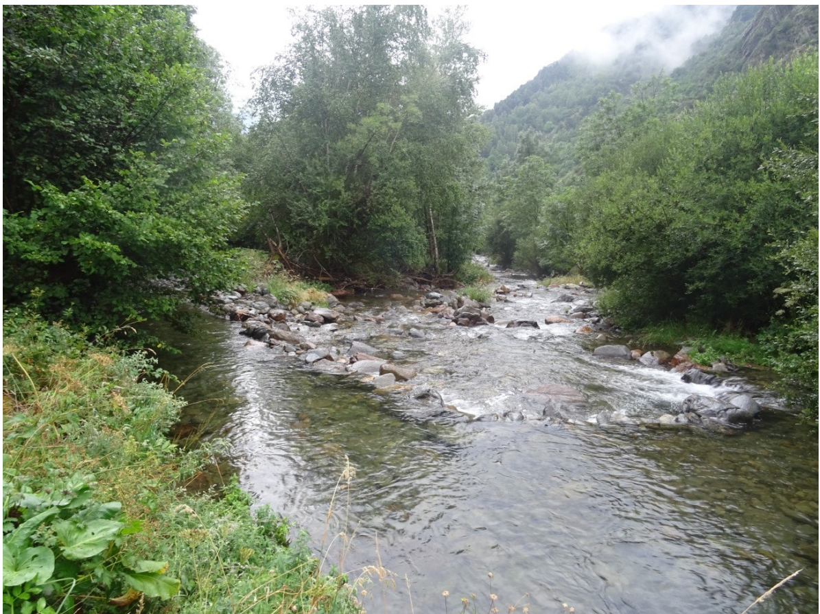
Azud de piedras y canal de derivación para riego de prados
