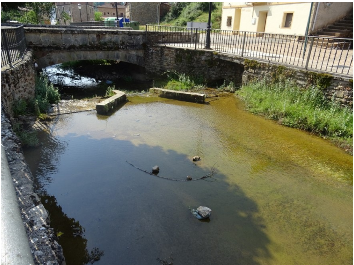
Canalización y obstáculo en el Najerilla a su entrada en Canales de la Sierra
