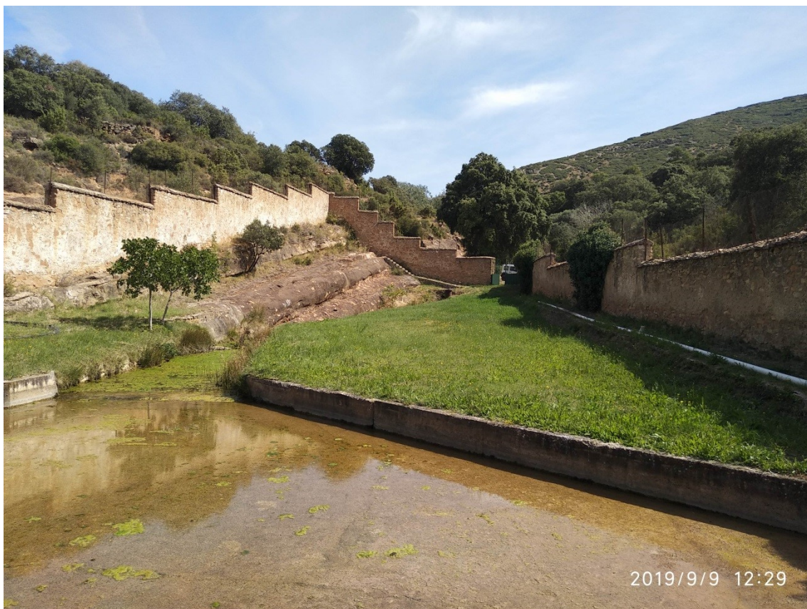
Interior del recinto de protección
