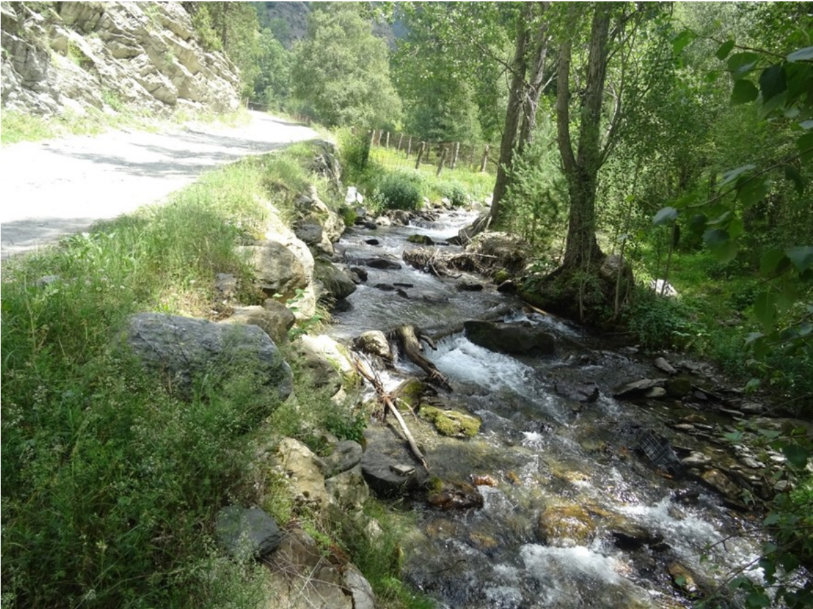
Pista protegida con escollera en DPH
