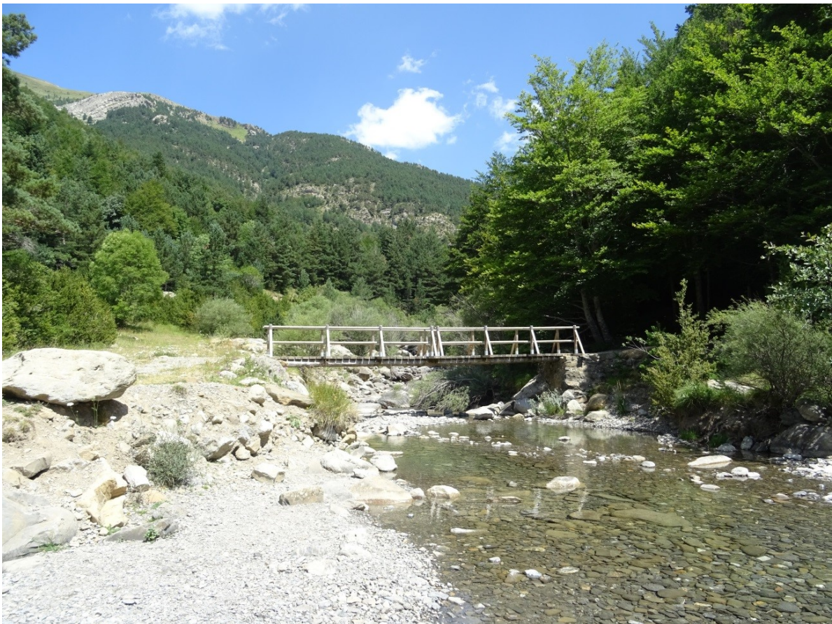
Pasarela localizada en la zona 2
