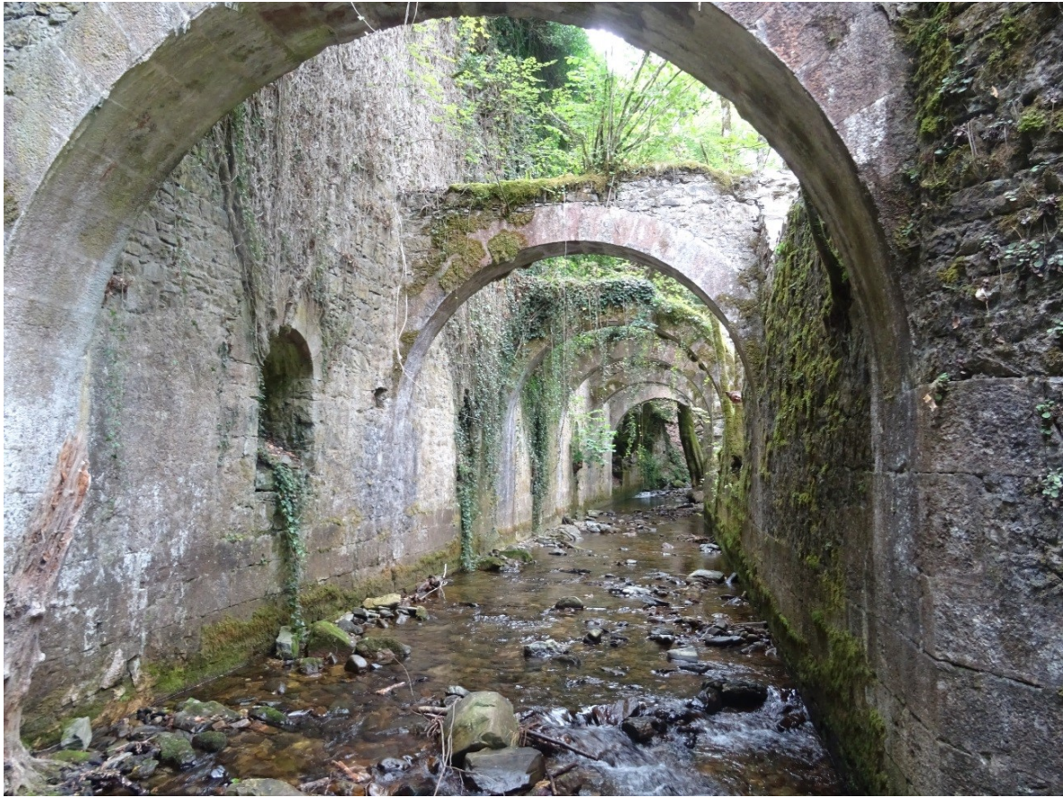
Arcos de la Real Fábrica de Municiones de Eugi sobre el río Arga
