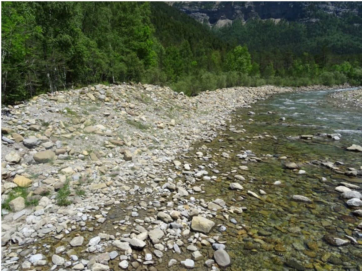
Acumulaciones de sedimentos a modo de defensa en el río Arazas
