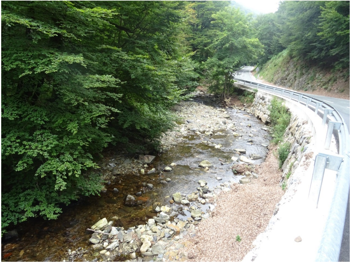
Escollera de protección de la carretera N-138 coincidente con el fin de la Reserva Natural Fluvial
