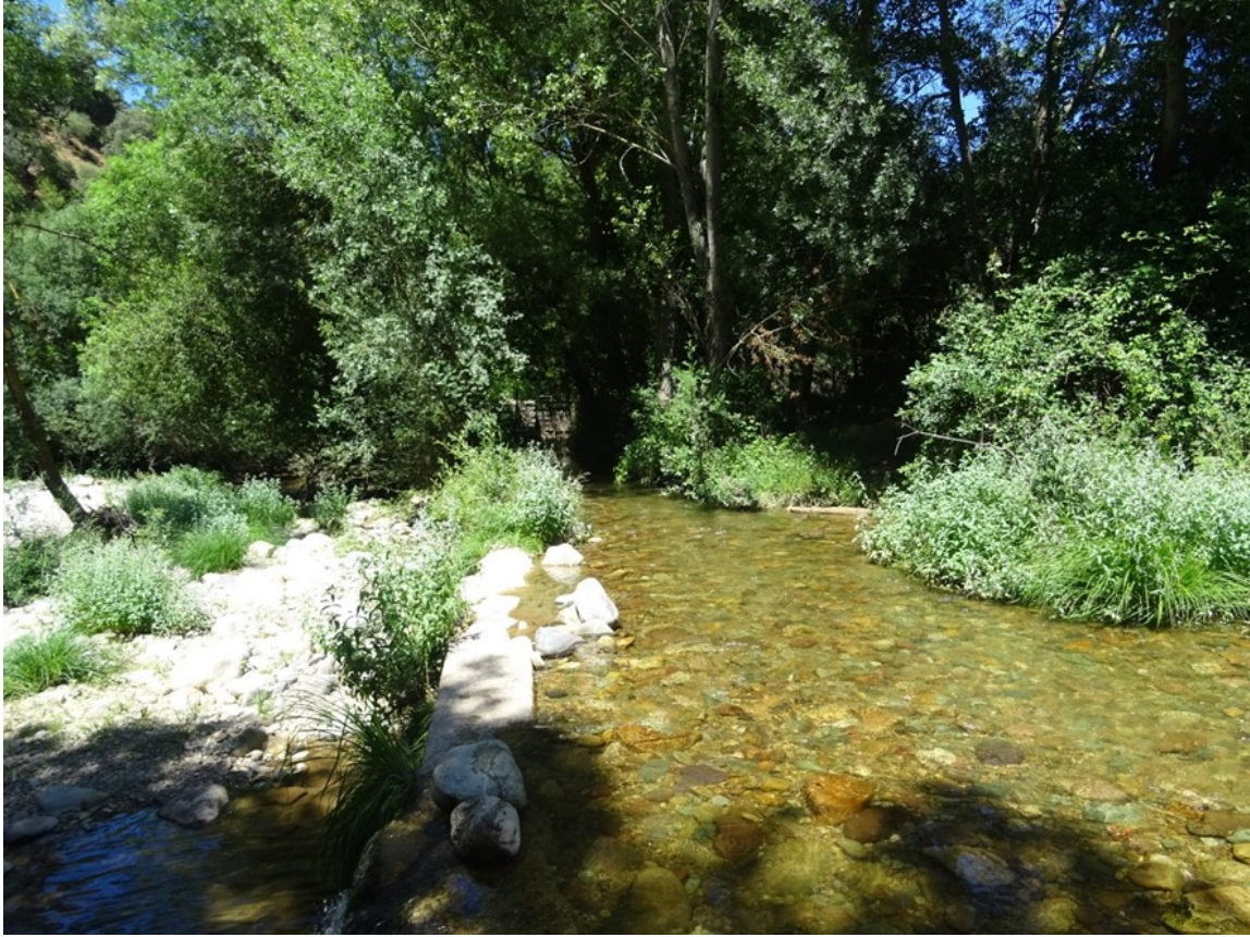
Azud con derivación a acequia en las proximidades de Viniegra de abajo
