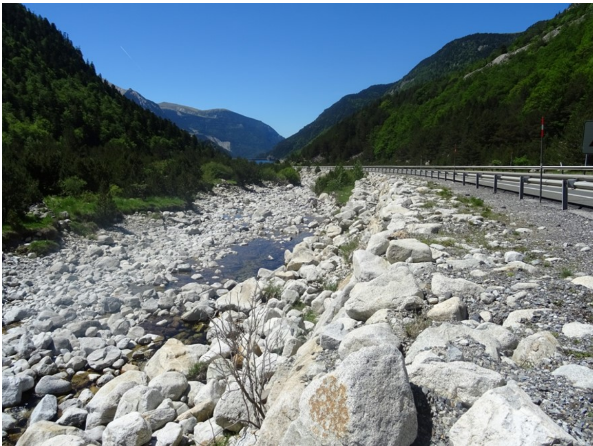
Carretera N-230 y escollera de protección en la margen derecha en tramo 5
