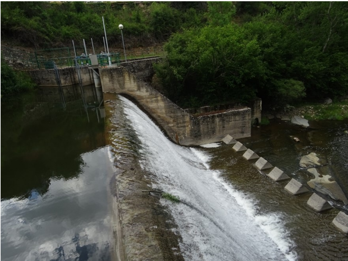
Azud del canal de trasvase al Embalse de Ortigosa, coincidente con el fin de la RNF
