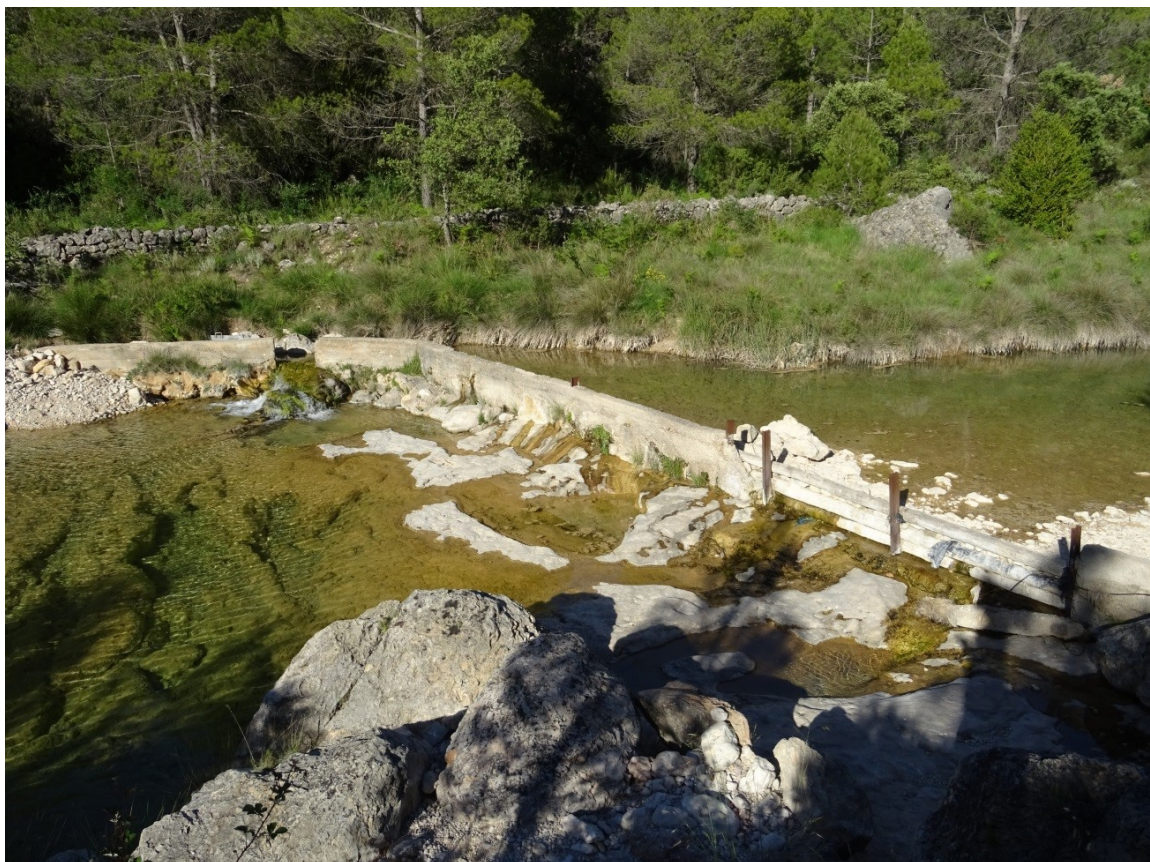
Azud con canal de derivación construido con hormigón y madera
