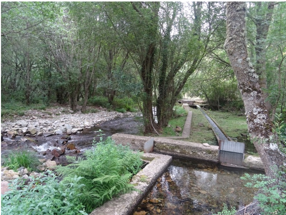
Captación existente en el fin de la RNF
