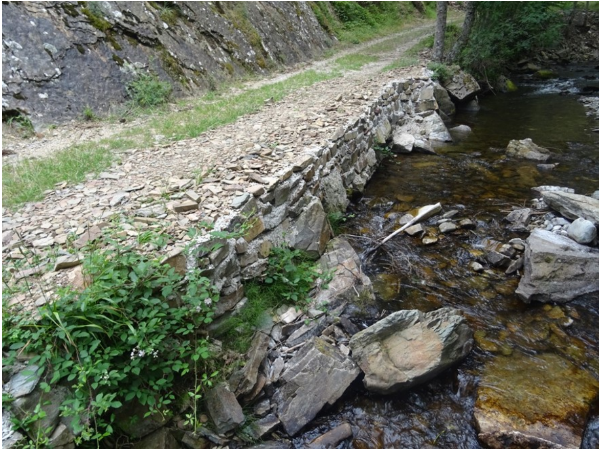
Muro de protección de la pista que discurre junto al río Calamantio
