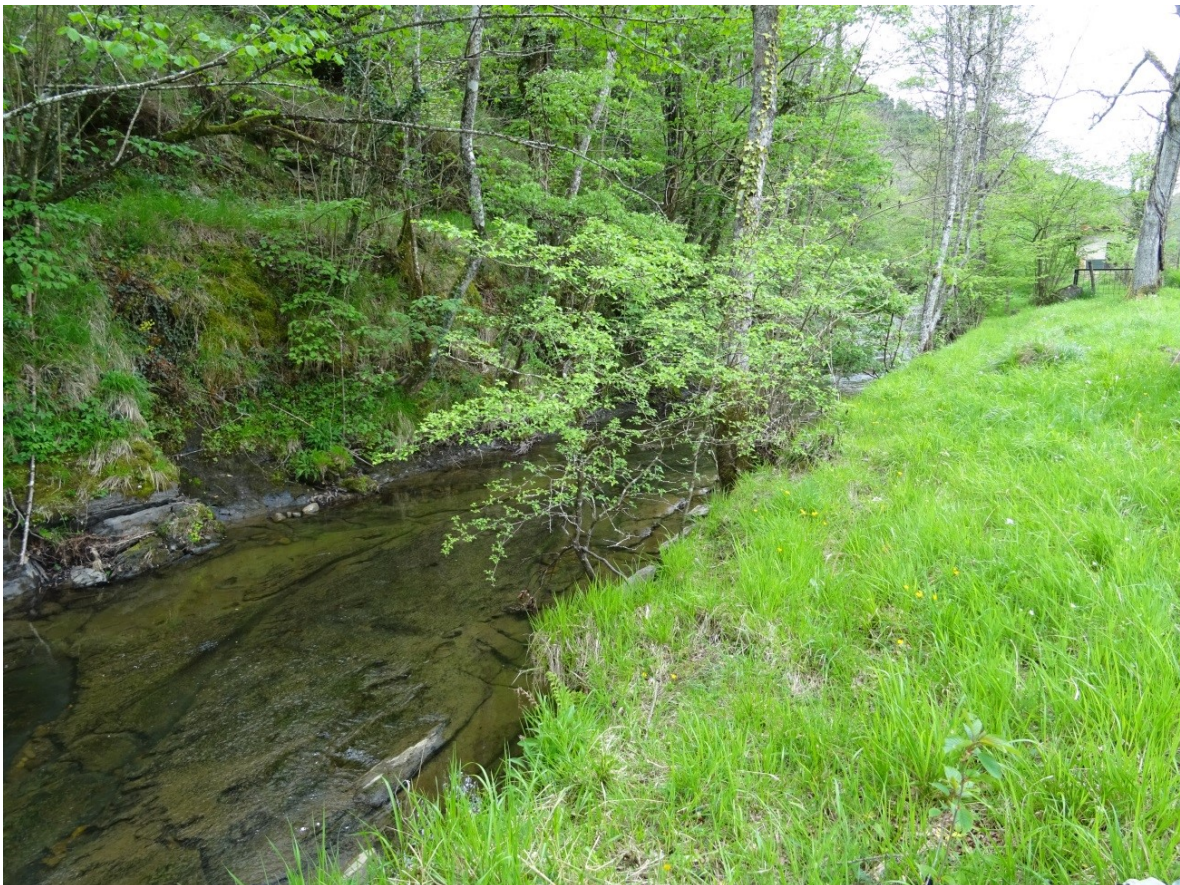
Terreno sobre elevado en la margen izquierda del tramo bajo del río Santa Engracia
