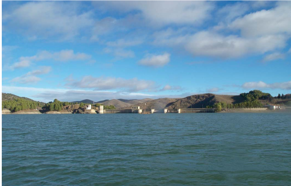
Vista de la presa desde la estación de muestreo (E1). Invierno de 2004 (02/12/2004)
