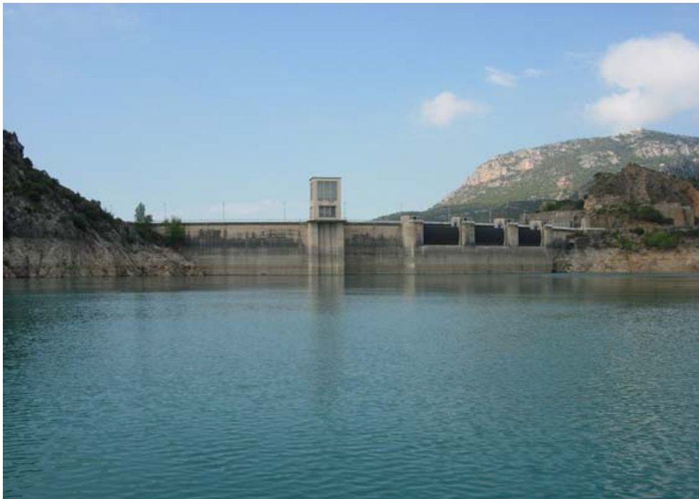
Vista de a presa desde la estación de muestreo (E1). Verano de 2005 (29/07/2005)
