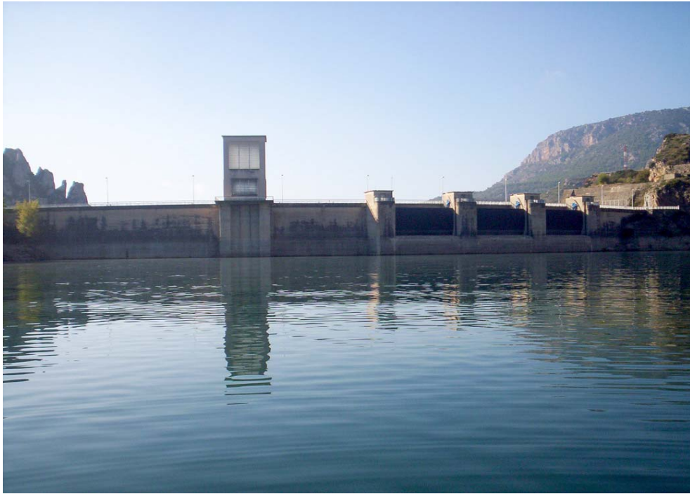
Detalle de la presa del embalse de Santa Ana. Verano de 2004 (04/08/2004)
