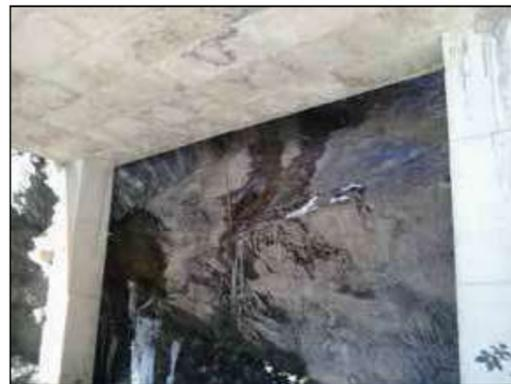
Diaclasa D1 en excavación tras el edificio
